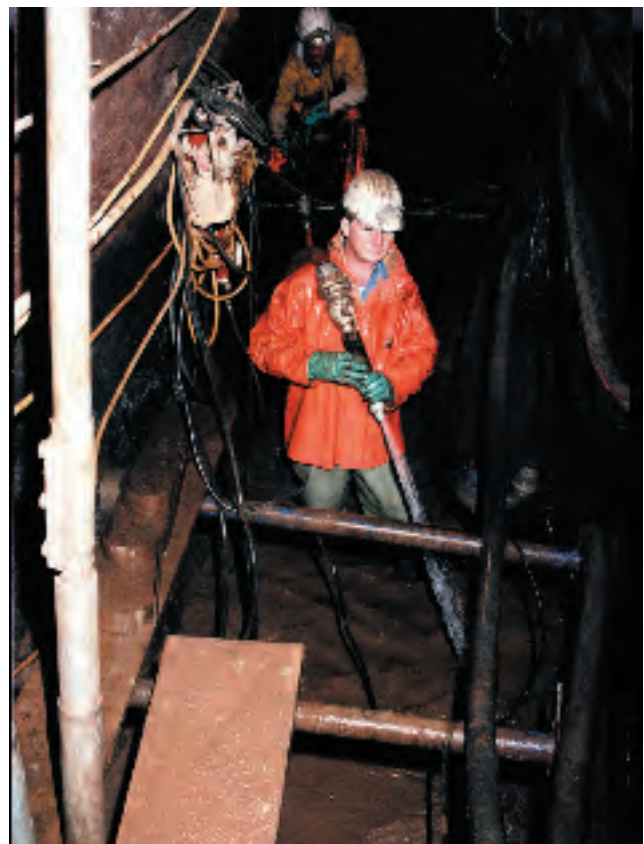
Abb. 10-23: Hydraulische Entschlammungsarbeiten im Tiefen Elbstolln; Foto: WEISSE
