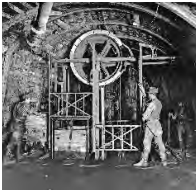
Abb. 9.2-9: Bremsschacht, kurzer Blindschacht zum Anschluss von Zwischen- an Haupt- streckensohlen. Königl. Steinkohlenwerke (s. Ausrichtungsschema von FÖRSTER); Foto: GEORGI et al. 1894: Abb. 3
