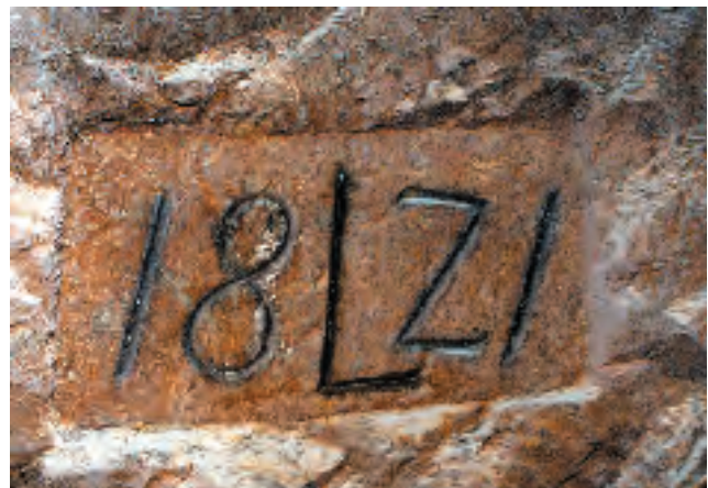
Abb. 14-5: „Tiefer Elbstolln“, bei 676 m. Das Vortriebs- und Gedingezeichen (auch Gedingestufe) bedeutet: Stand des Vortriebes Jahresende 1821. Der Stollen wurde von rechts nach links aufgeföhren. Das Zeichen (die „Stufe“) musste der Berggeschworene einschlagen. Foto: SCHAUER
