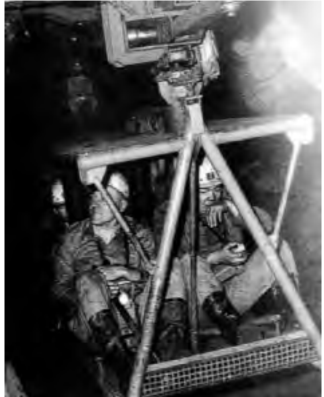
Abb. 10-22: Steigorttransporteinrichtung (Einschienenhängebahn) für Lasten- und Personentransport, Gstbg. 930 Gf. Bannewitz-Nord; Foto: SDAG Wismut (MAI et al. 1999: 50)
