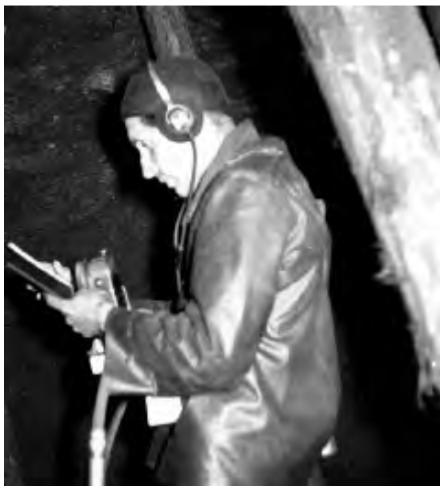
Abb. 10-2: Radiometrist mit Bohrlochradiometer (1958), Intensitätsabschätzung durch akustische und visuelle Anzeige, Grube Dr.-Gittersee, 2. Sohle Aufh. 6, Mai 1958; Foto: REICHEL
