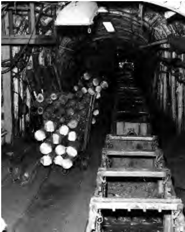
Abb. 10-21: Holztransport mit gleisgebundenem Container (rechts) und Umschlag auf den Ketscher; Foto: SDAG Wismut
