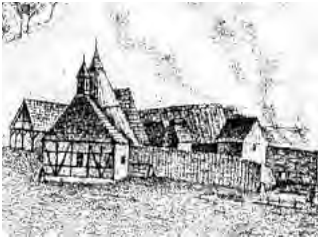
Abb. 14.6-9: Gebäude der ersten Burgker Gasanstalt mit Gasometer im Fachwerkhaus und (verdeckt) einer Göpelkaue unbekannter Funktion. Burgker Steinkohlenwerke, Freital-Burgk, Windberg Allee; Lithographie von 1835 - Bildausschnitt, Original SSB
