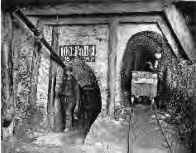
Abb. 9.2-10: Unterbergsstrecke (hier 100. Fallstrecke), wichtige Abwetterwege und Verbindungen zwischen den Hauptsohlen (s. Ausrichtungsschema von FÖRSTER). Ausmauerung der elliptischen Streckenprofile mit Plänersandstein und Ziegeln. Königl. Steinkohlenwerke; GEORGI et. al. 1894: Abb. 29
