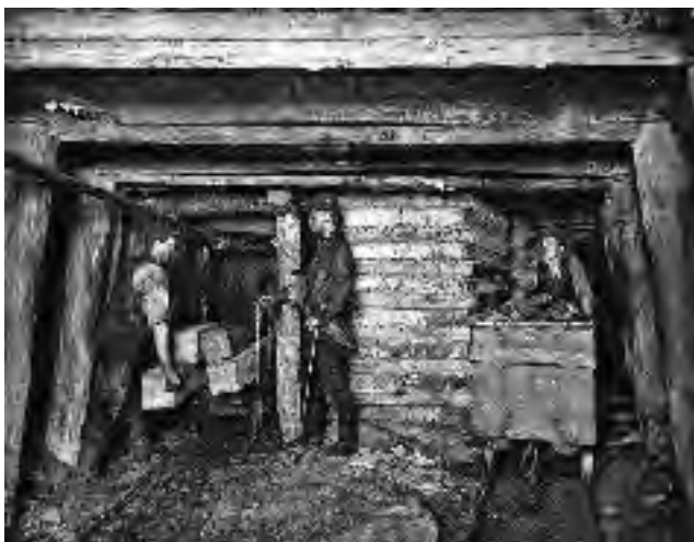
Abb. 14-25: Kompakter Holzpfeiler an Streckenabgang, rechts ein Huntestößer, links ein Fördermann mit einem „Holzketcher“. Königl. Steinkohlenwerke; Foto: GEORGI et al. 1894: Abb. 18
