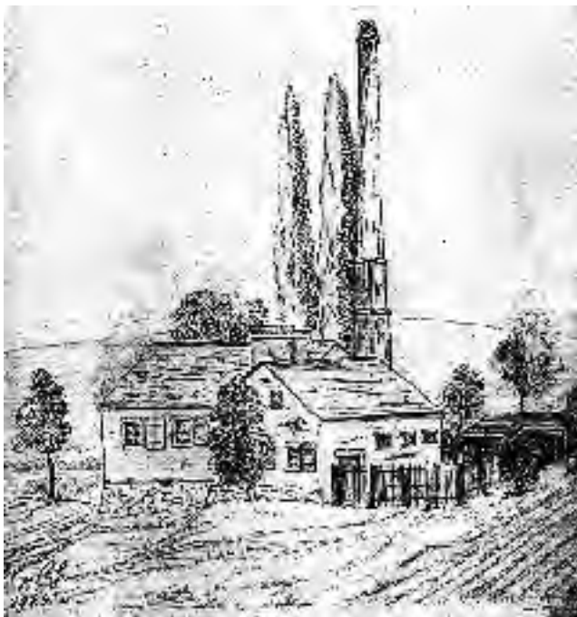
Abb. 14.5-1: Gebäude am Mehner Schacht mit dem Schornstein des Wetterofens. Königl. Steinkohlenwerke, Freital-Zauckerode; Bleistiftzeichnung - Original SSB
