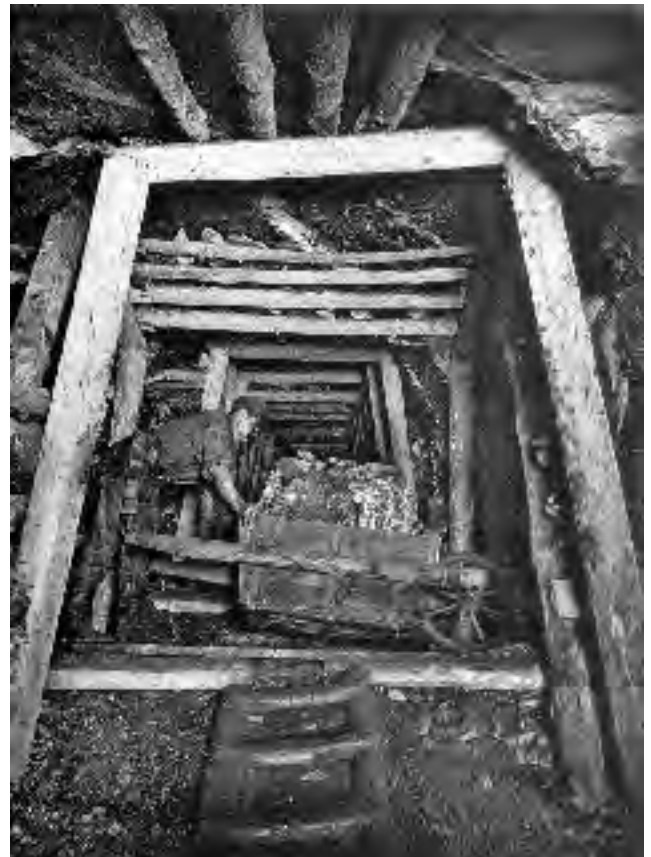
Abb. 14-7: „Karrenläufer“, gleislose Förderung untertage mit Schubkarren. Über dem Rücken ein Tragegurt. Die Karrenholme waren am Kasten nur angeschraubt, zur rationellen Reparatur; Foto: GEORGI et al. 1894: Abb. 17
