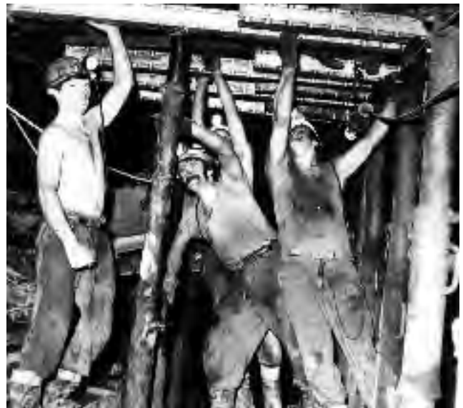
Abb. 10-18: Ausbau im Abbau mit Hydraulikstempel und Aluminiumhohlkappen Foto: SDAG Wismut
