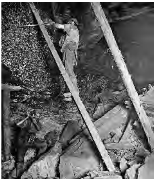
Abb. 14-12: Bohren eines Sprengloches aus dem aufgebrochenen Bruchfeld zum Gewinnen der Dachkohle des 1. Flözes. Verm. Königl. Steinkohlenwerke; Foto: GEORGI et al. 1894: Abb. 15
