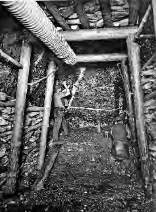
Abb. 14-19: Vortrieb einer Streichstrecke im 1. Flöz. Deutscher Türstockausbau mit eisernen „Heftnägeln“ und Bergemauer am Streckenstoß. An der Firste eine „Lutte“ (Blechrohr) zur Bewetterung. Verm. Königl. Steinkohlenwerke; Foto: GEORGI et al. 1894: Abb. 7
