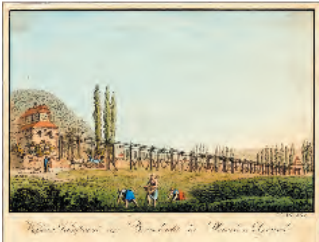
Abb. 9.2-4A: Feldgestänge zum Döhlener Kunstschatz. Schönberg'sche/Königliche Steinkohlenwerke. Links das Haus für das Wasserrad mit dem „Glöcklein“ als Umdrehungsanzeiger, dahinter der Windberg. I. C. A. RICHTER - Original Slg. SSB
