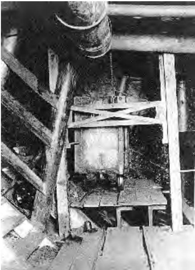
Abb. 14-8: Bühnenwagen zum Huntetransport in stark geneigten Grubenbauen (Bremsbergen), Königl. Steinkohlenwerke; Foto: BÖRNER 1893, SSB
