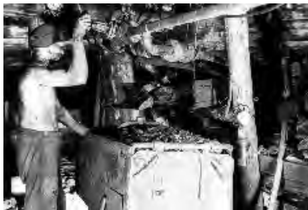
Abb. 14-13: Huntetüllung über Schüttelrutsche aus Streibabbau, Rutsche Pressluftantrieb (siehe Handrad), Döhlener Hunt, Geleucht: kleine Mannschafts-lampe. Verm. 17. Sohle, Paul-Berndt-Grube, 1950; Foto: Deutsche Fotothek Nr. 104392
