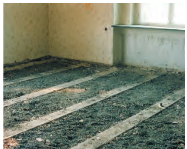
Abb. 14.8-6: Steinkohlenschlacken (häufig radioaktiv kontaminiert) zur Isolation der Zwischendecken von Wohn- und Bürogebäuden; Foto: SCHAUER (1993)
