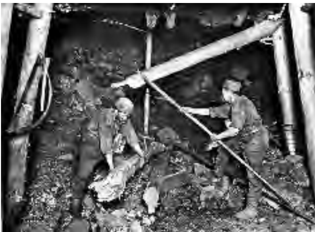
Abb. 14-24: Rauben alter Grubenzimmerung mit dem Raubhaken zur teilweisen Weiterverwendung. Über dem linken Zimmerling das „Blatt“ der Kappe, rechts vom anderen die Kaffeekanne. Offenes Geleucht. Verm. Königl. Steinkohlenwerke Foto: GEORGI et al. 1894: Abb. 14
