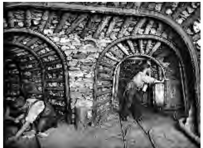
Abb. 14-22: Ausbau eines Streckenabgangs mit Stahlbogensegmenten in Kombination mit Bergepfeiler (Mitte) und mit Bergen hinterfüttetem Holzverzug. Verm. Burgker Steinkohlenwerke (Holzhunt) Foto: GEORGI et al. 1894: Abb. 28
