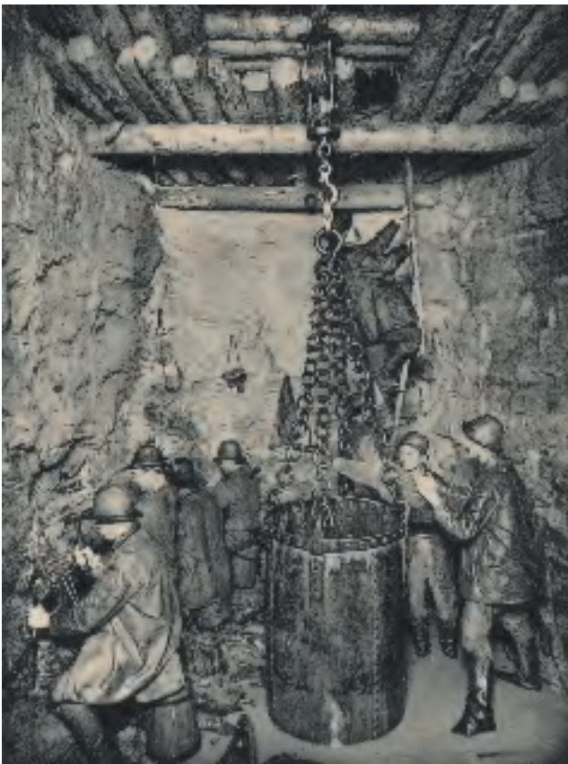
Abb. 9.2-13: Schachtteufen. Die Aufnahme stammt etwa von 1890, daher dürfte es die Teufe des Marien Schachtes der Burgker Steinkohlenwerke sein. Links 4 Häuer beim Bohren mit Schlegel (Fäustel). Kübelförderung. Am schmalen Schachtstoß Tscherpertasche, links u. rechts offene Ölgeleuchte ungewöhnlicher Bauart. Rechts Fahrung auf Eisenfahrten; Foto: GEORGI et al. 1894: Abb. 4
