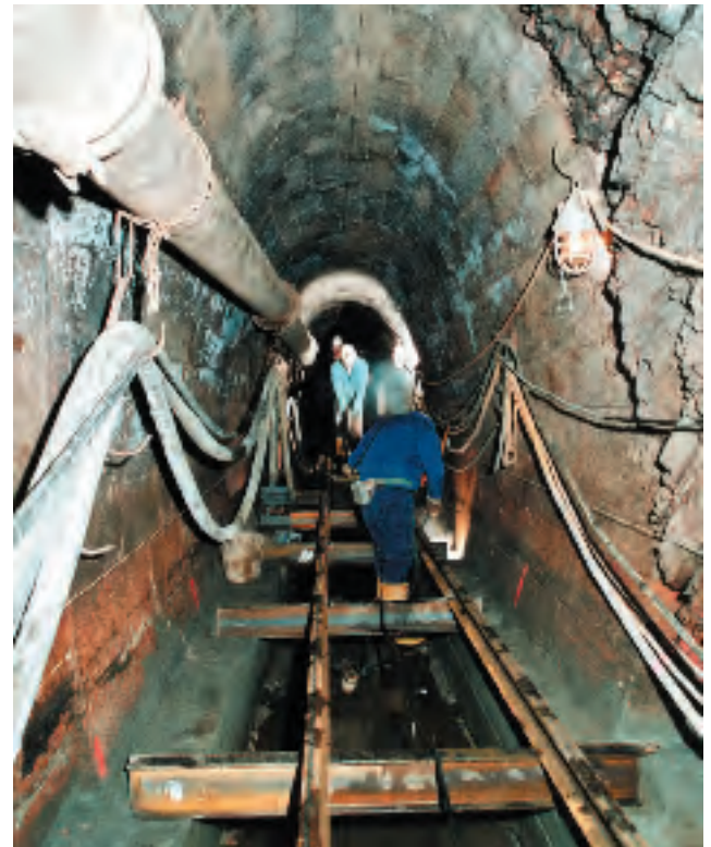
Abb. 10-25: Ausmauerung mit Sandstein und Einbau der Gleisanlage im Elbstolln bei 5330 m; Foto: HAUSTEIN
