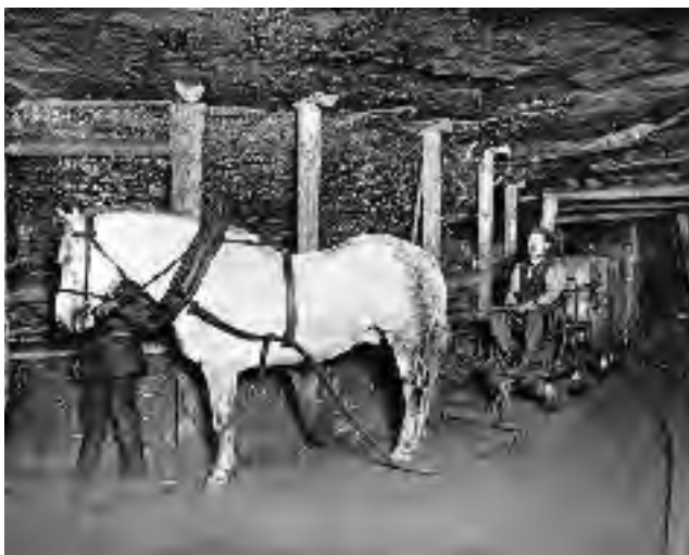
Abb. 14.4-1: Pferdeförderung. Ausbau bei geringem Druck nur mit Kopfstempeln und Quetschkeilen. Verm. Königl. Steinkohlenwerke; Foto: GEORGI et al. 1894: Abb. 20
