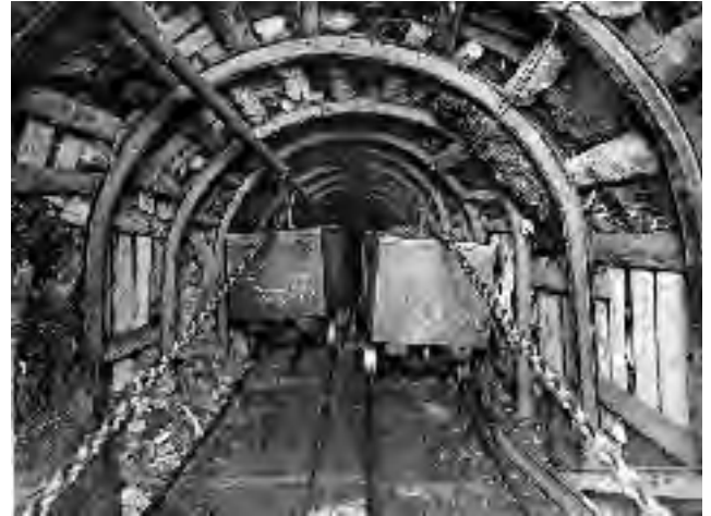
Abb. 14-21: Förderung mit „Kettenbahn“, endlose Kette läuft in Gabeln auf den Hunten, meist auf geneigten Strecken. Königl. Steinkohlenwerke Foto: GEORGI et al. 1894: Abb. 22
