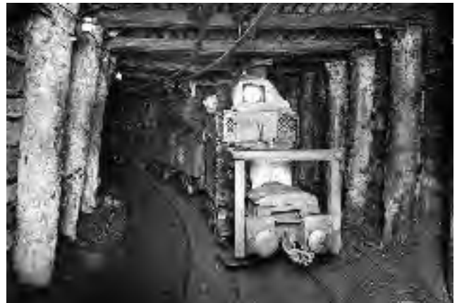
Abb. 14.4-3: Erste elektrische Grubenlokomotive „Dorothea“ auf dem Hauptquerschlag 5. Sohle, Oppel Schacht Freital-Zuckerode. Besonders zu beachten ist die Handbedienung der Stromabnehmer. Der Querschlag ist wegen seiner Bedeutung mit Holztürstöcken und Eisenbahnschienen als Kappen ausgebaut. Königl. Steinkohlenwerke Foto: GEORGI et al. 1894: Abb. 23
