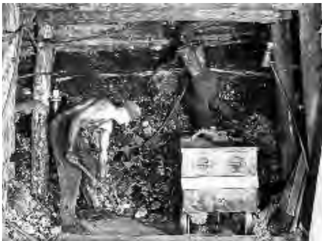
Abb. 14-10: Huntefüllung durch Schaufeln von der Stahlplatte, Gewinnung mit Pickhammer; Geleucht: kleine Mannschaftslampen, Döhlener Hunt. Kammer zur Wetterstrecke 17. Sohle Ost, Paul-Berndt-Grube, 1950, Foto: Deutsche Fotothek Nr. 104393
