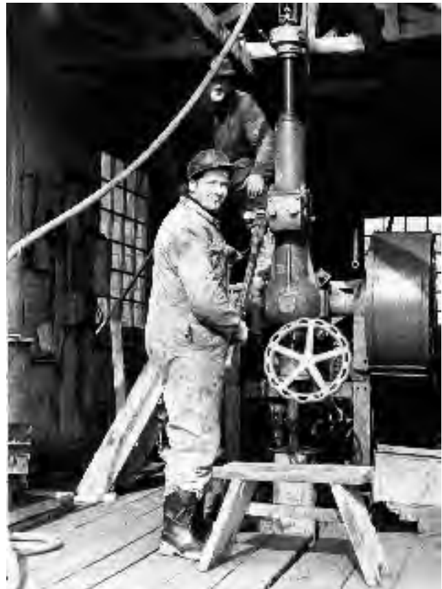
Abb. 9.2-19: Bohranlage vom Typ Craelius (verm. SIF 500, Gerät-Nr. 186). Mit diesem Gerät wurden 1958-1962 die Bohrungen Freital 6 bis 15, mit Maximaltiefe von 730 m, geteuft; Foto: REICHEL
