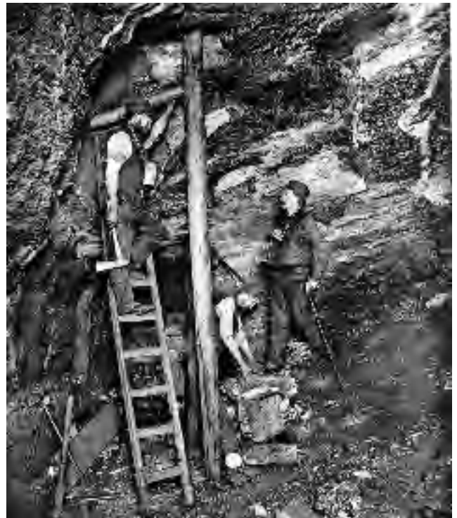
Abb. 14-11: Gefährliche Arbeiten beim Aufbrechen der Dachkohle aus einer Förderstrecke heraus; Foto: GEORGI et al. 1894: Abb. 8
