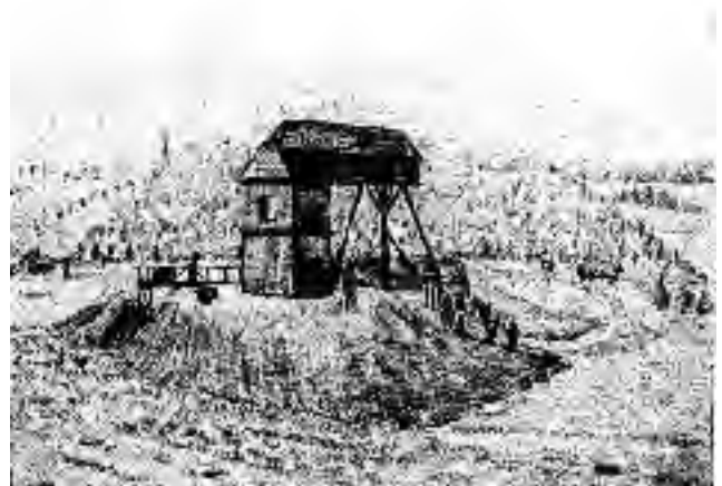
Abb. 14.4-13: Göpelwerk am Alexander Schacht. Königl. Steinkohlenwerke, Freital-Zuckerode; Original Deutsches Museum München, Kopie SSB
