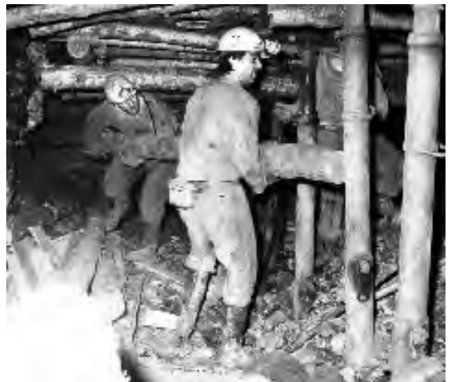
Abb. 10-17: Ausbau im Abbau mit Hydraulikstempel und Holzkappen; Foto: SDAG Wismut
