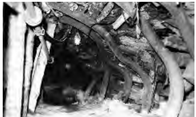
Abb. 10-19: Deformierte Stahl-Polygonbaue einer Strecke an der Grenze zu einem Bruchfeld; Foto: SDAG Wismut
