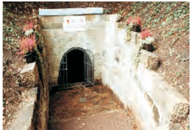
Abb. 14.9-4: Bergbaudenkmal : Rösche des Segen Gottes Schachtes mit Sandstein Ausmauerung. Poisentalstraße, Freital-Niederhäslich; Foto: STUTE
