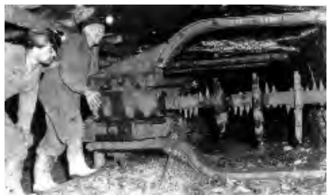
Abb. 14-18: Einsatz einer Kirowez-Schrämmaschine im 3. Flöz, Streb 342/343 - NW Marien Schacht 1963/64, Foto: Autor unbekannt
