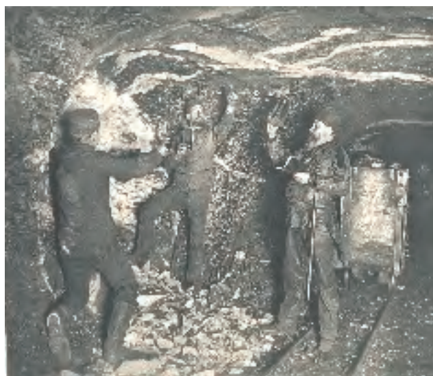
Abb. 14-15: Gedingestellung durch den Obersteiger Freyberg. Geleucht offene Freiburger Blenden. Holzhunte, daher Burgker Steinkohlenwerke. Im Kohlenflöz horizontale helle Tonsteinlagen (die Letten), helle klastische Gänge (die Kämme) durchsetzen steil das 1. Flöz. GEORGI et al. (1894, Abb. 6)
